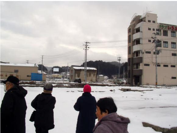
右のビルの4～5階(地上約10㍍)お踊り場の手すりがちぎれて無くなっている。水線も残っている。見上げて約10㍍上が水面！
