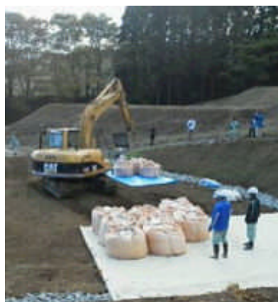
ゼオライトの上にフレコンバッグに詰めた焼却灰 飛灰を置きます。「埋め立て」というより「置いている」という感じです。
