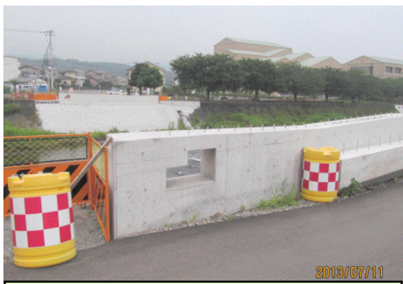
新しい柳端橋の下部工事が終わりました。
