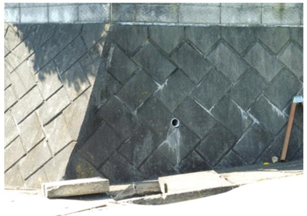
千福が丘1丁目付近で側溝の蓋が外れ、側溝横の道路が陥没するということが発生しました。連絡を受け確認に行ったところかなりひどい状況になっていましたので、土曜日でしたが、担当職員さんに連絡いたしました。当日のうちに応急対策をしていただき、数日のうちには補修工事が完了しました。原因は1日深夜の暴風雨により水
