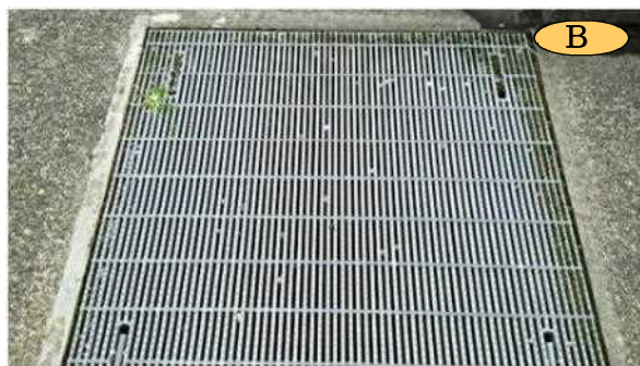
取り替えられたグレーチング。 隙間が小さいので安心感があります。
